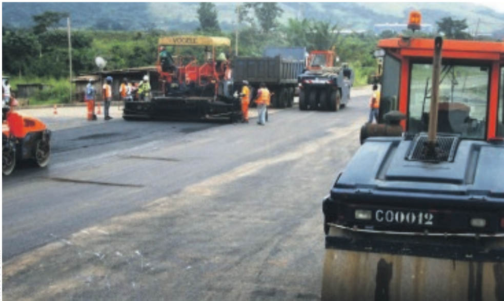
Une vue des engins mobilisés pour accélérer les travaux.
