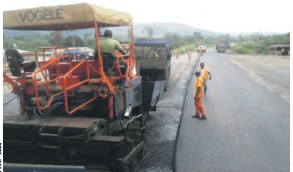
Les ouvriers à pied-d'oeuvre sur l'axe Gare ferroviaire-Centre-ville.
