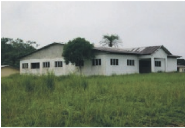
Le bâtiment du Conseil départemental à l'abandon.
