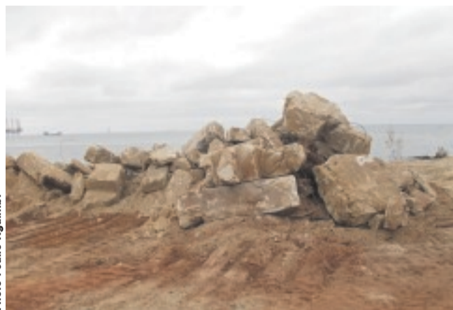
Vue du chantier.
