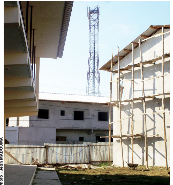
Ce pylône de téléphonie mobile sert de transmission pour la collecte des données des transmissions.
