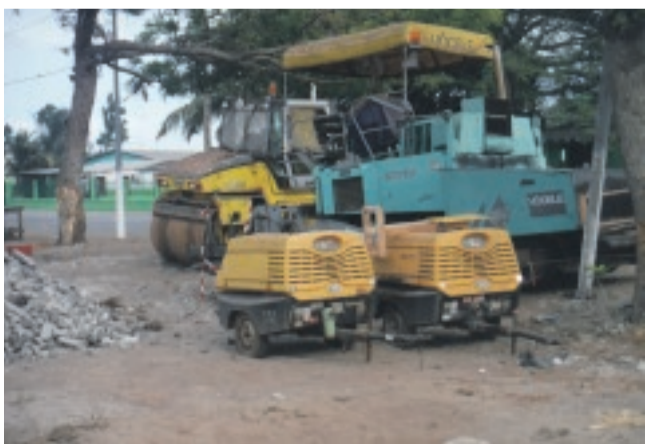
Des engins commis aux travaux à la Cité Shell.
