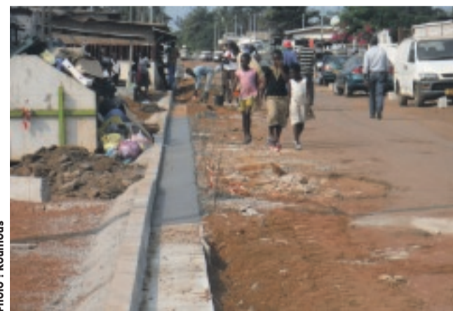
Les travaux de reprofilage ont déjà commencé dans le quartier.
