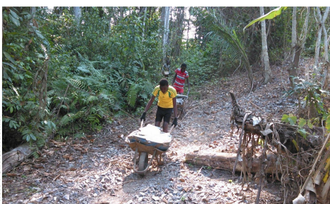
Avec des brouettes en très mauvais état, le transport des blocs au lieu du concassage n'est pas chose aisée.
