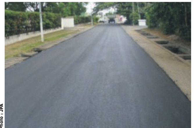
L'axe routier reliant les locaux de l'opérateur de la téléphonie mobile Moov au front de mer.
