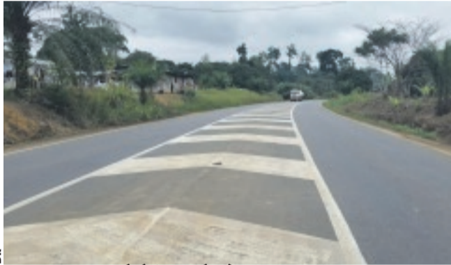
La victime a été fauchée à ce niveau, avant le pont de Woubele.
