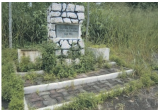
Le monument à l'entrée du cimetière : les herbes attestent de la non-évolution du chantier.
