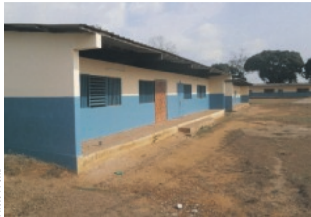
Une vue des bâtiments après la cure de jouvence.
