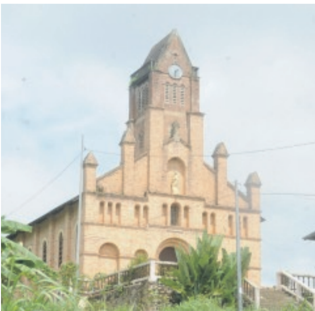
Bénéficiant d'une architecture qui ne laisse personne indifférent, l'église Saint François Xavier, avec ici son horloge défectueuse, mériterait d'être réhabilitée.
