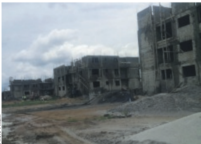
Les immeubles de la SNI, situés à Angondjé, peinent à avancer faute de financement.
