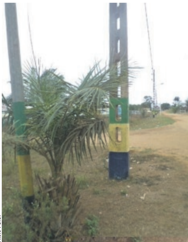
Malgré la présence de poteaux électriques et de lampadaires, il n'y a pas d'éclairage public à Mayumba.
