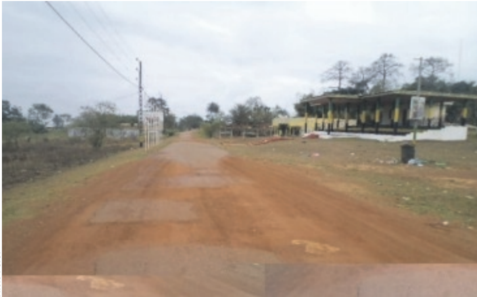
La principale voie de la ville est dans un état piteux.
