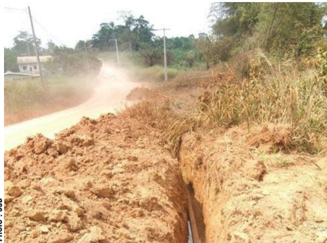
Les travaux d'adduction d'eau avancent.
