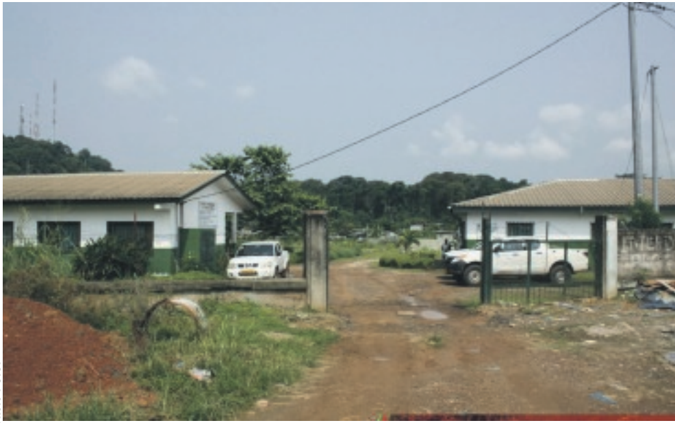
L'entrée principale de l'Igad, sis à Sibang (PK 8), dans le 6e arrondissement de Libreville.
