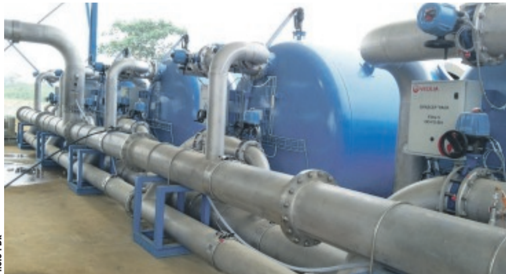
L'eau sera acheminée dans ces turbines, puis stockée...
