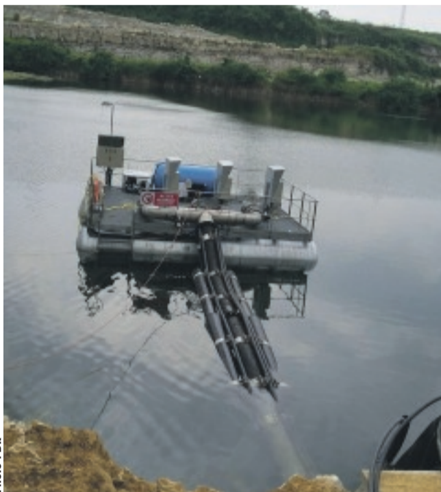
Une vue d'un collecteur d'eaux brutes.
