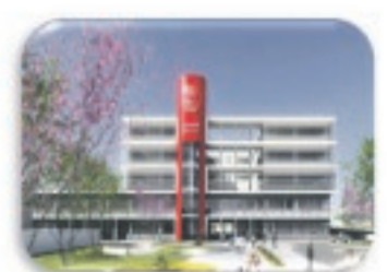
CHU FJE (en cours de finition)
