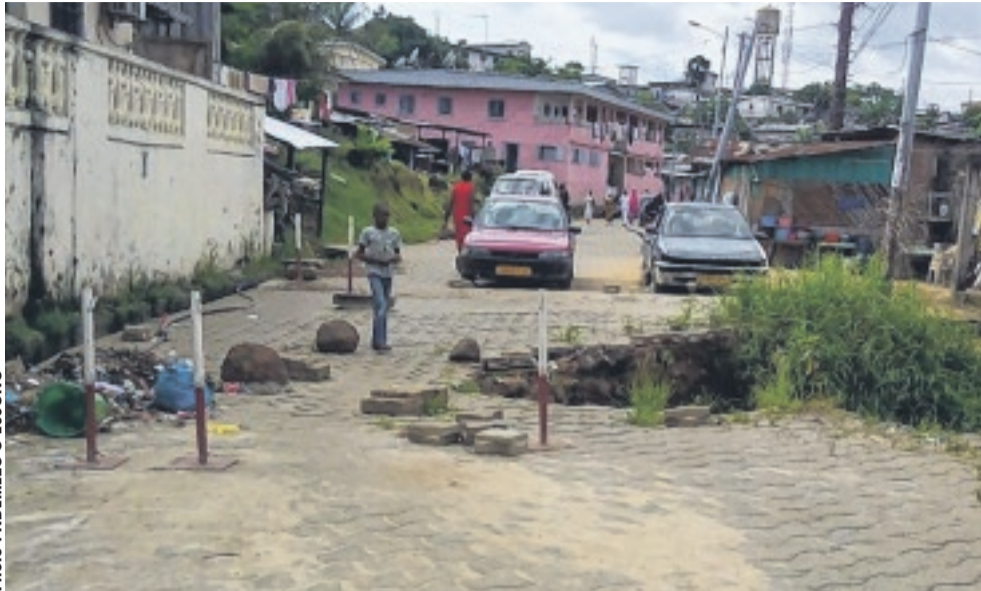
La buse ayant été emportée par les eaux, la chaussée s'écroule progressivement.
