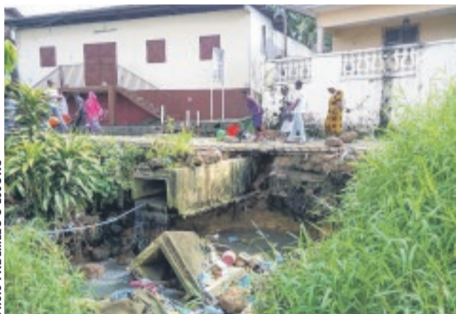
Une vue de la dégradation de l'environnement, après que la buse a été emportée par les eaux de pluie.
