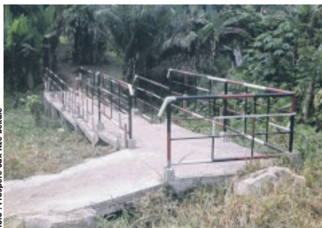
La passerelle du quartier Nkan : un ouvrage qui permet la circulation en toute sécurité pour les usagers.
