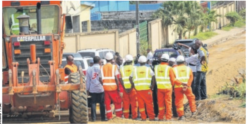
Les engins de Colas sur un chantier.
