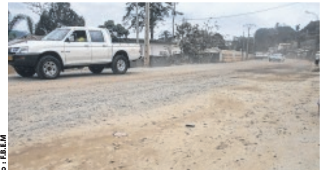
La route nationale traversant la ville de Lambaréné va également être réhabilitée.
