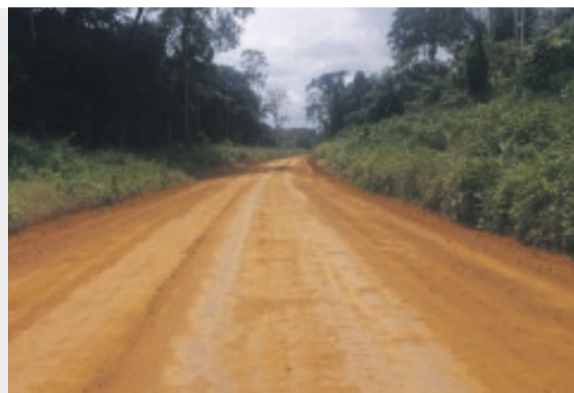
Photo de droite: Une route rénovée
