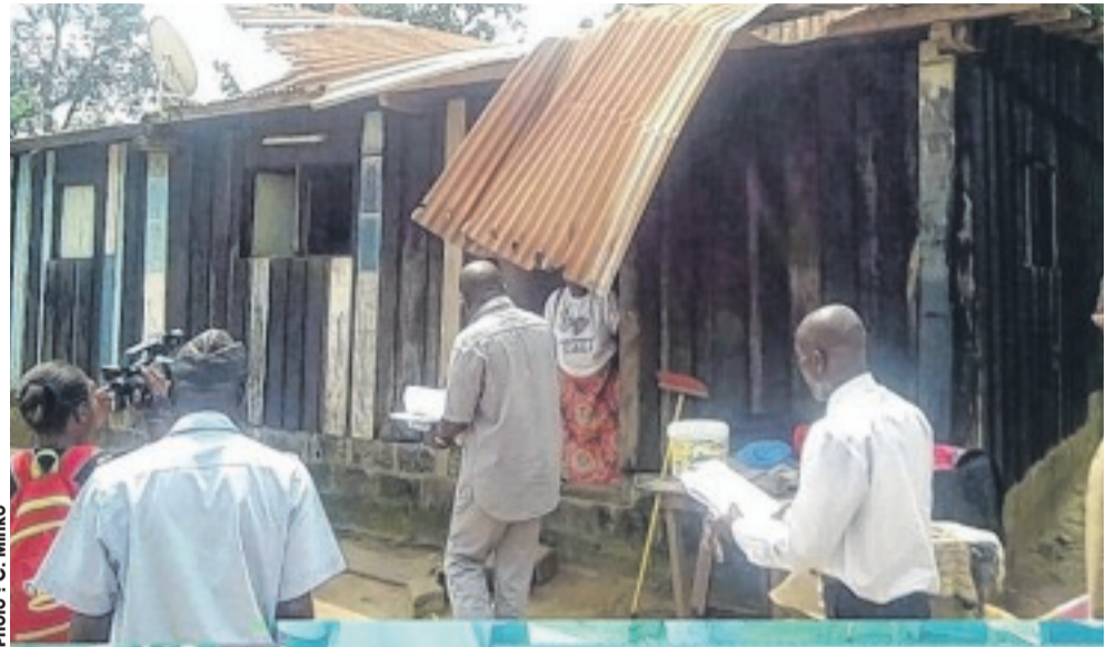
... ont rencontré dans chaque quartier les sinistrés et évalué l'ampleur des dégâts.
