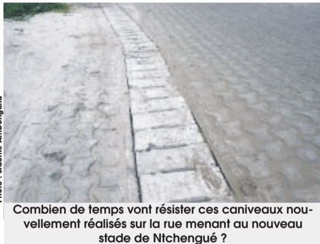
Des caniveaux réalisés au même niveau que la chaussée.
