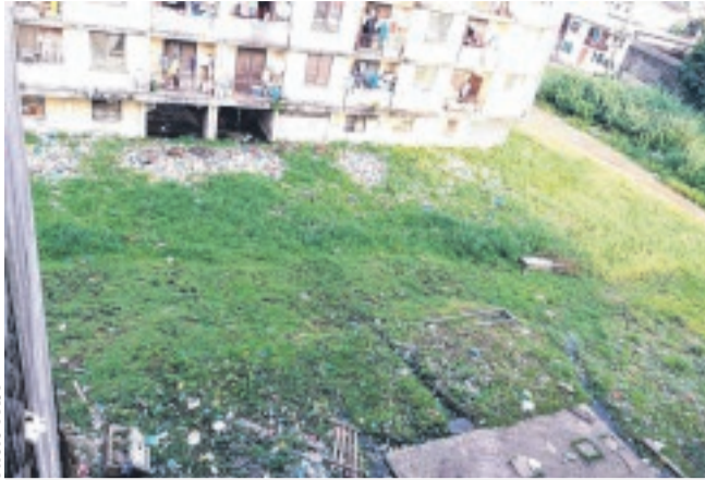
Tout autour des bâtiments...
