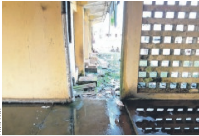
Les eaux usées à l'entrée des bâtiments.
