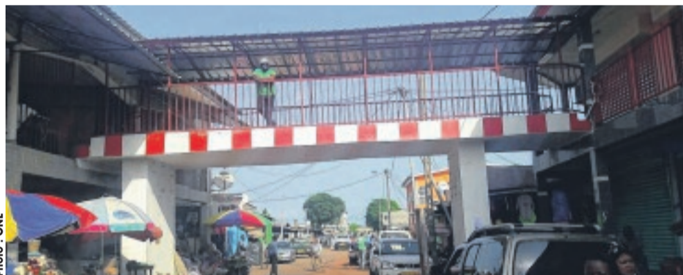
La première passerelle déjà livrée.
