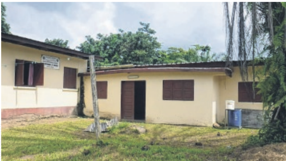
Le dispensaire de Bendjé, nouvellement réhabilité...
