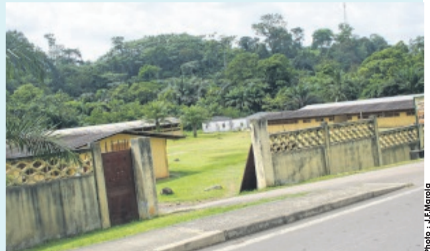
L'un des murs du lycée professionnel
