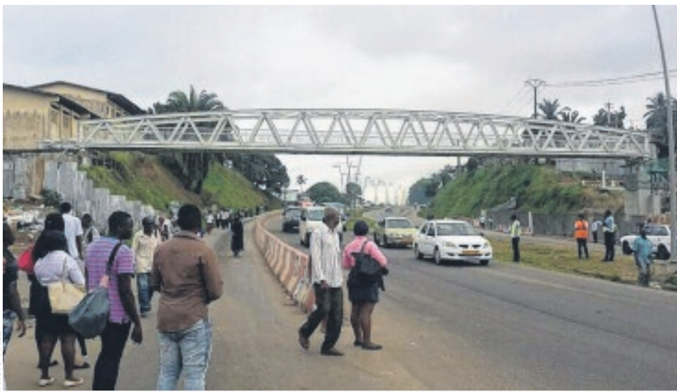
La passerelle piétonne installée à Plein-Ciel.
