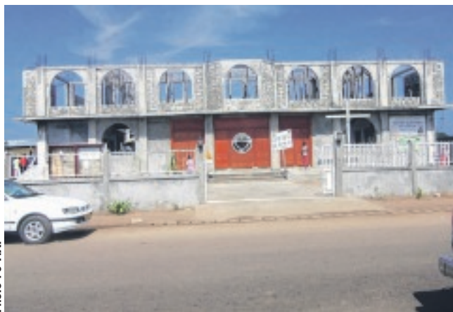
Une vue de l'église Sacré-Cœur de Bac-Aviation encore en chantier.
