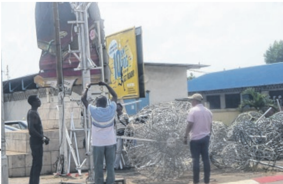
Une phase du démontage des lumières...
