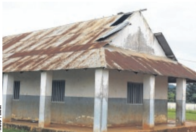
Un des bâtiments de l'école publique de Lébamba. Sans commentaire !
