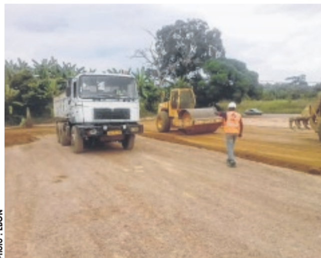
Les engins de la société EGBTP procédant à la pose de la dernière couche de latérite.
