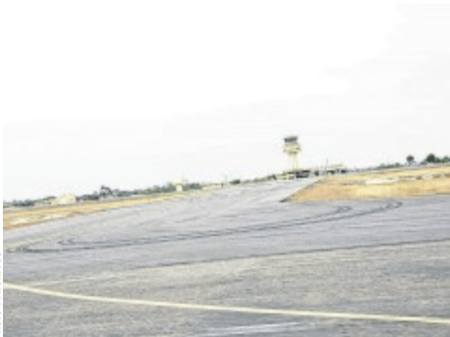
Les travaux de réfection des chaussées aéronautiques débutent le 10 juillet prochain.
