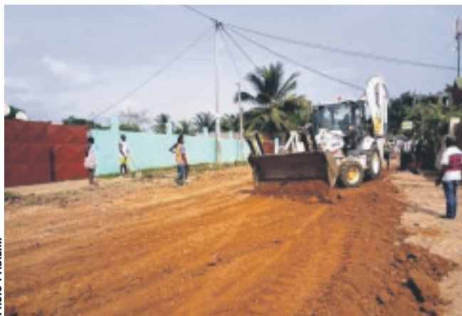
Un aperçu du tronçon en réfection.
