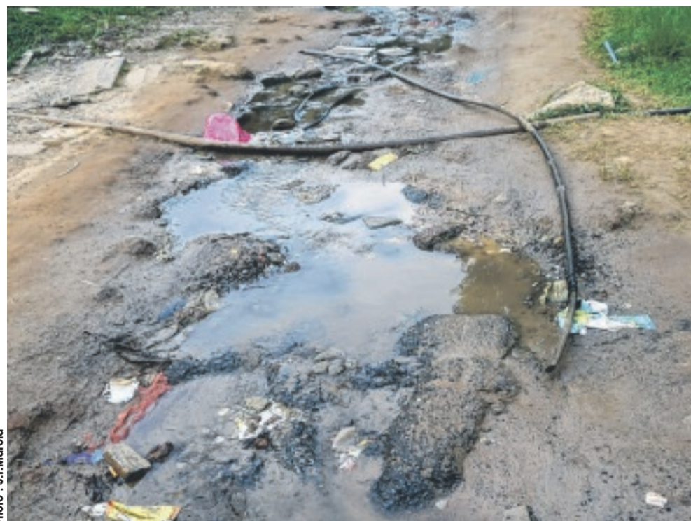
Conséquence des installations anarchiques : des tuyaux éclatent au passage des véhicules.
