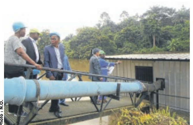
La délégation, en visite sur les installations d'une prise d'eau brute.
