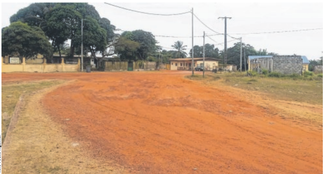
A Gamba, une grande partie du réseau routier communal est en mauvais état.
