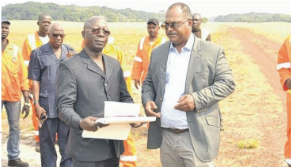
Le président du Conseil départemental de Ndougou (g), lors du lancement des travaux de construction d'une route à Gamba.
