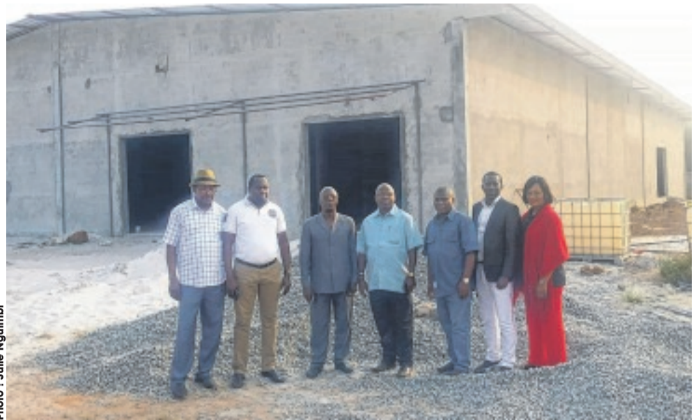
En arrière-plan, on aperçoit le nouvel espace commercial. Le chantier est actuellement à l'arrêt.
