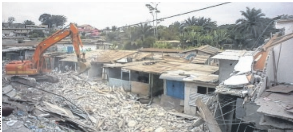
Les engins de Colas, démolissant les box des commerçants du PK 12 hier.
