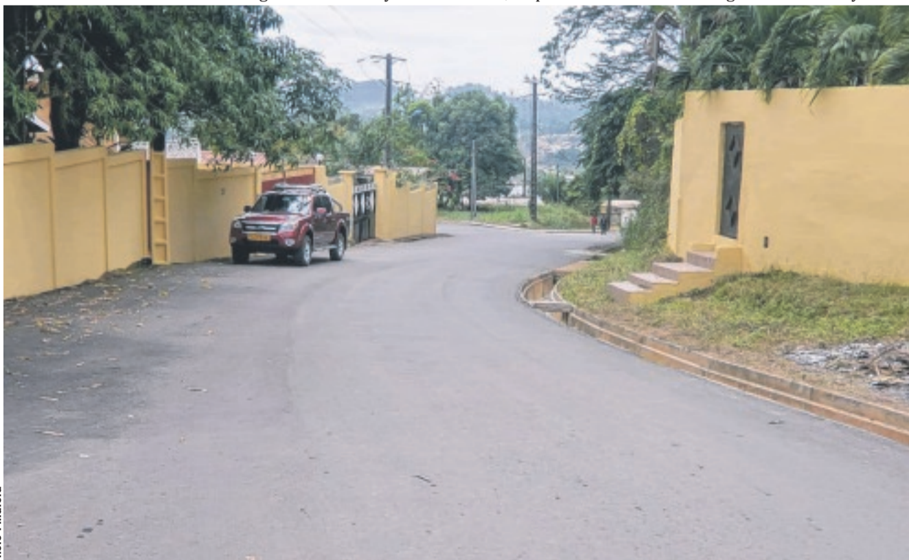
Une autre voie bitumée au quartier Atongo-Wanga.
