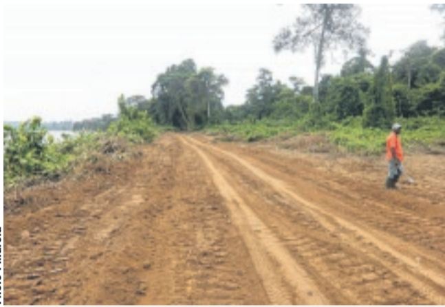
Des travaux dans la zone dite Lambaréné 3.
