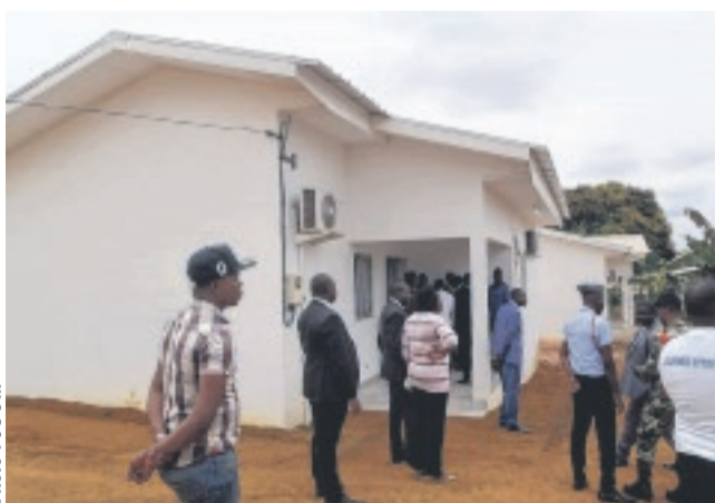
Les logements d'astreinte de la BCPFN de Ntoum.
