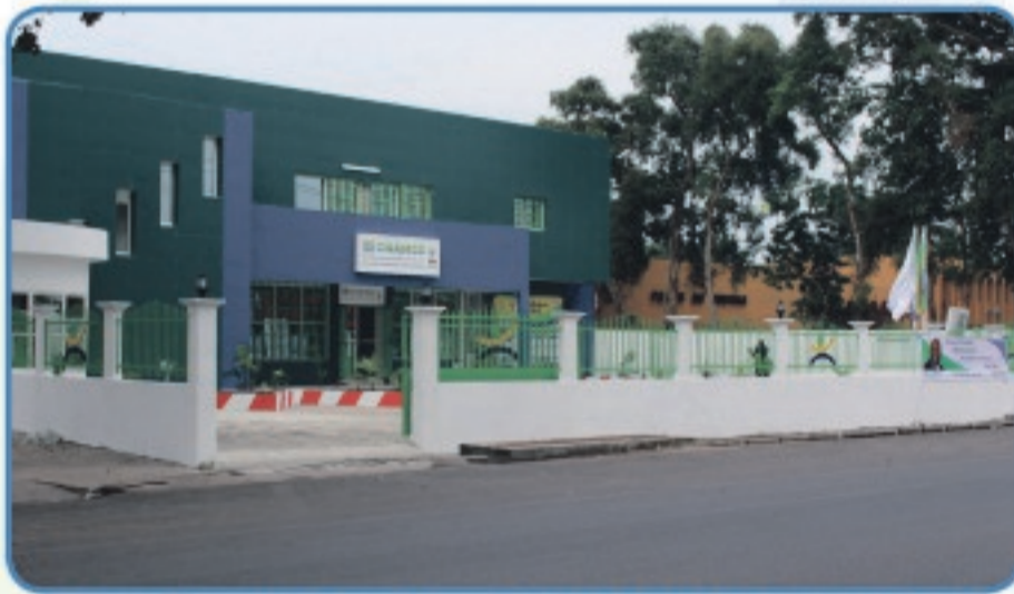
Délégation provinciale de l'Ogooué-Maritime, réhabilitée et livrée le 26 juin 2016 à Port-Gentil en présence du Président de la République, S.E. Ali Bongo Ondimba.
