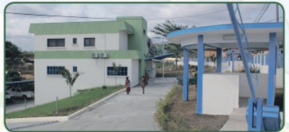
Délégation provinciale du Haut-Ogooué, réhabilitée et livrée le 28 septembre 2013 à Franceville en présence du Ministre de l'Economie, de l'Emploi et du Développement Durable, Luc Oyoubi.
