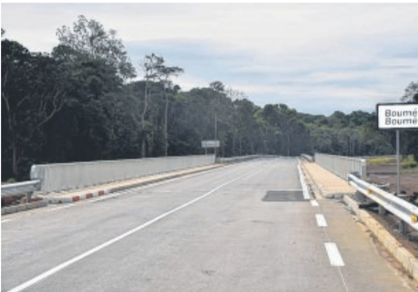
Le pont de Boumé-Boumé permet désormais de se déplacer facilement entre Gamba et Tchibanga.
