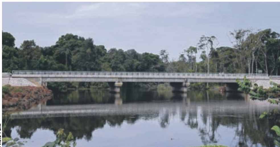
Le pont sur la rivière Boumé-Boumé : une véritable prouesse architecturale réalisée par une entreprise gabonaise.
