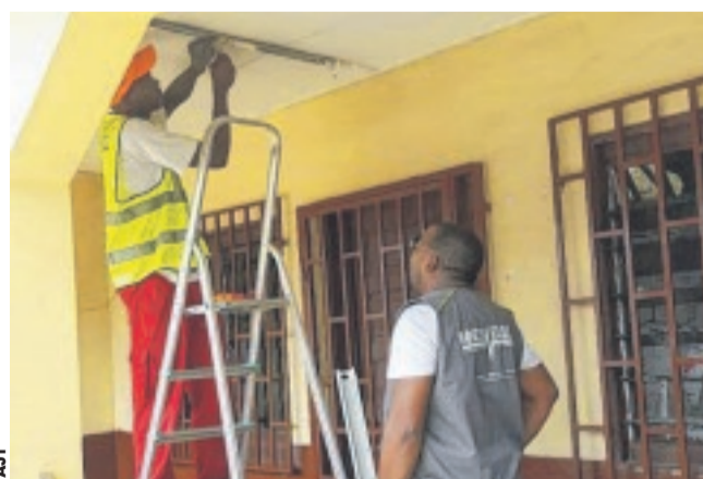
.. et les travaux de réparation du centre de santé de Louis.
