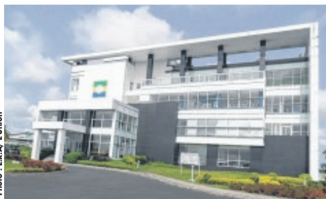
Le bâtiment abritant l'Autorité administrative de la Zerp de Nkok.
