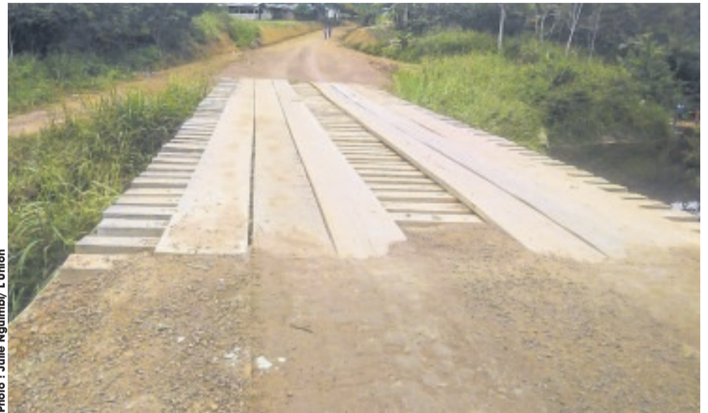
une vue du nouveau pont.
