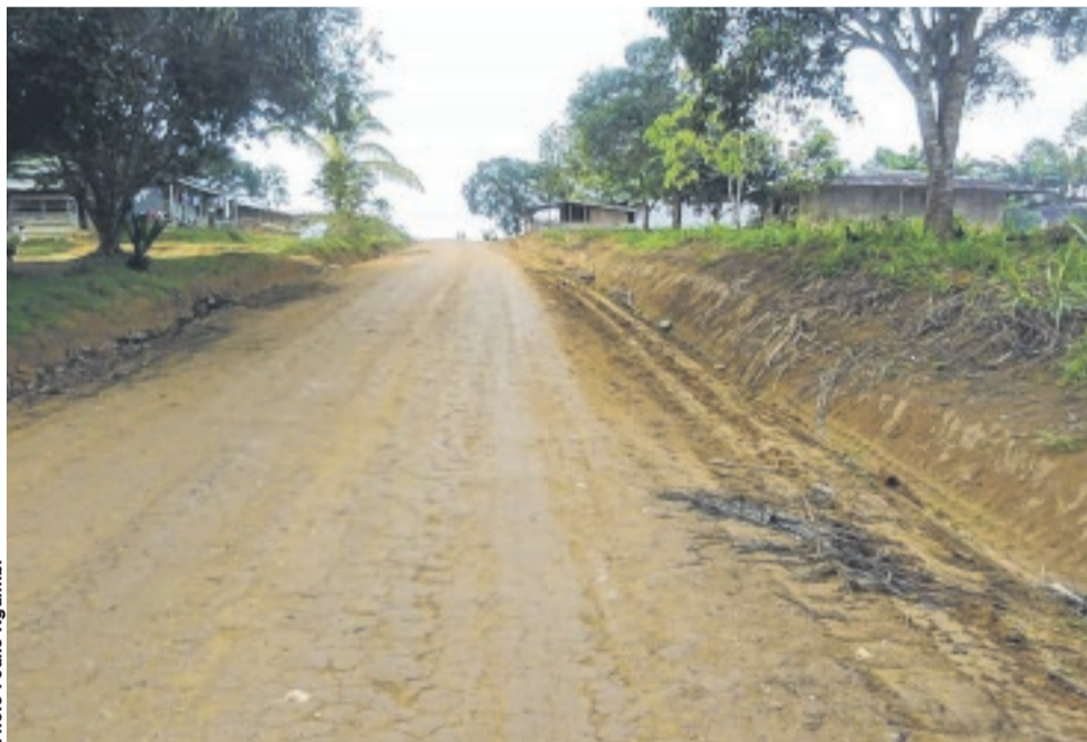
Une vue de la route d'Akam Essatouk aménagée.
