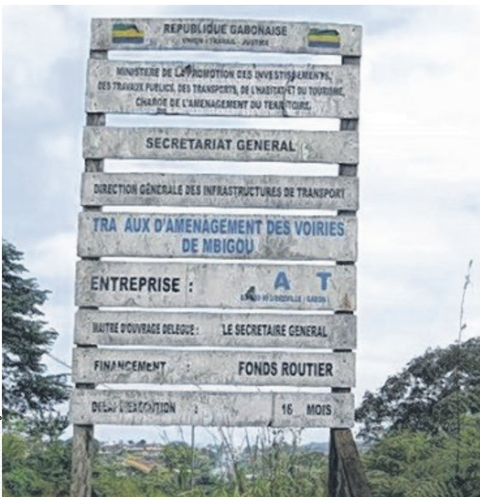
Ce panneau reste l'un des éléments encore vivants d'un chantier abandonné depuis belle lurette.
