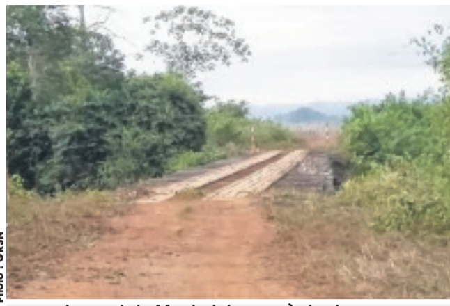
Photo : GRSN Le pont de Moukalaba, après les travaux d'enseiement.
