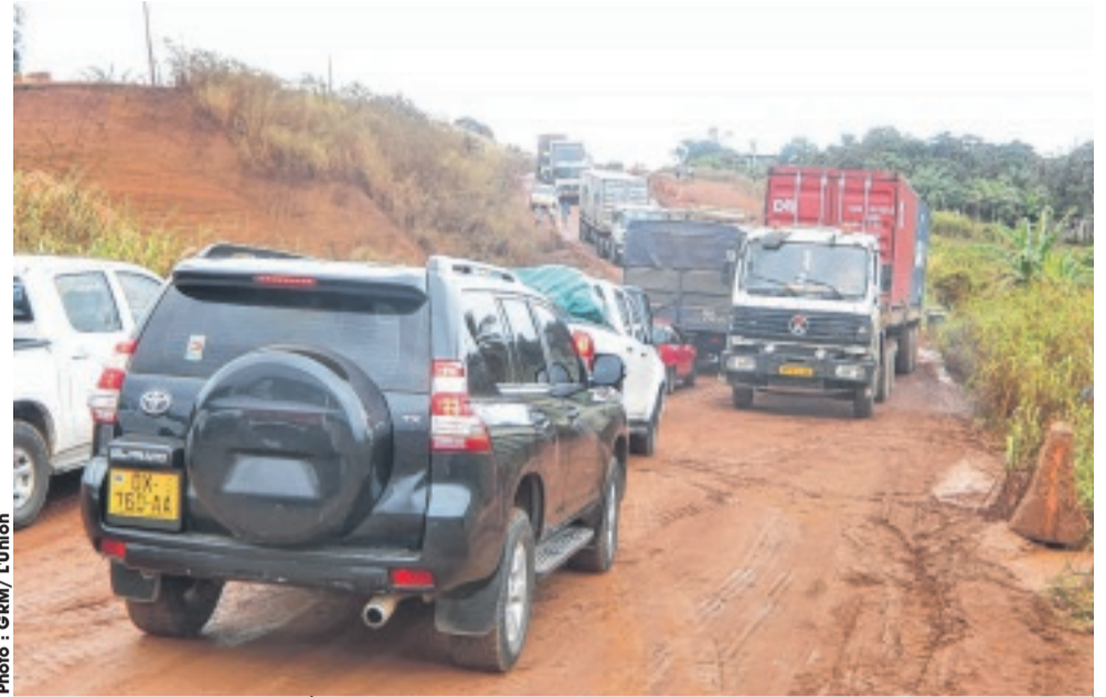
Si des travaux sérieux ne sont pas entrepris, on devrait revivre ce type de spectacle, la voie de la Nationale étant très pratiquée.
