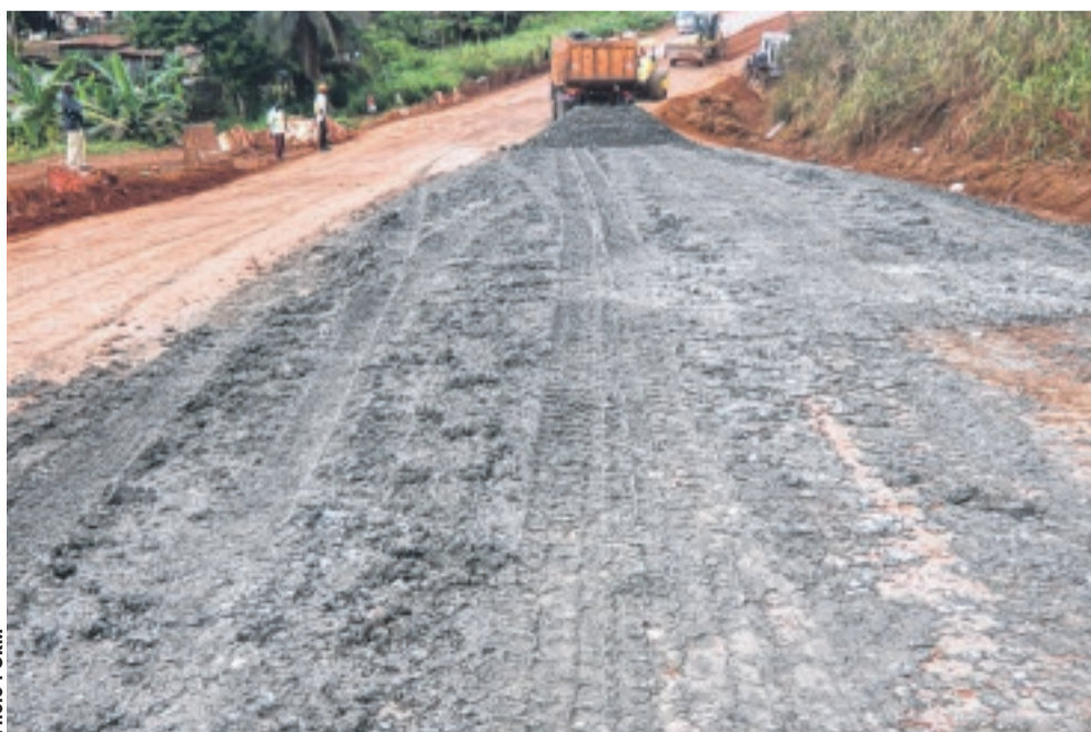
Une phase de la pose du stérile pour éviter la glissade.
