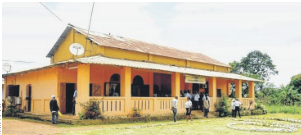
Une vue du bâtiment vétuste abritant actuellement le commissariat de Mouila.
