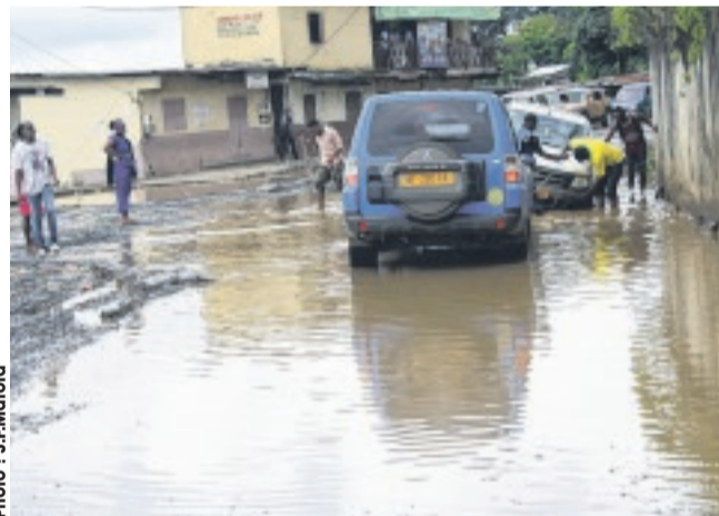
L'état de la route de Venez-voir avant les travaux.
